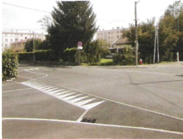
Figura 4.8. Cruce elevado en Grenoble (Francia)
