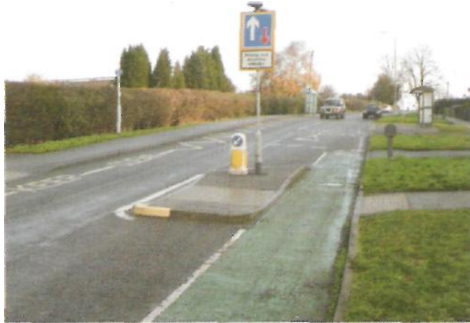
Figura 4.5. Estrechamiento de una calzada en Loughborough (Reino Unido)
