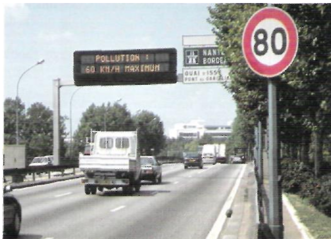
Figura 6.2. Ejemplo de inconsistencia entre señales de mensaje fija y variable
